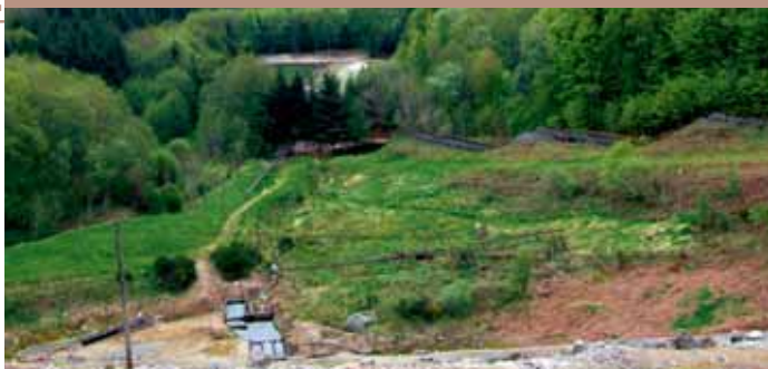
Vue des bassins de décantation et de traitement des eaux issues du site minier de Saint-Priest-La Prugne (Loire) avant rejet dans le milieu naturel (rivière la Besbre).
