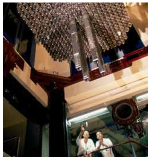
Vue de dessous du réacteur MASURCA, pendant la descente des barres de combustible.
