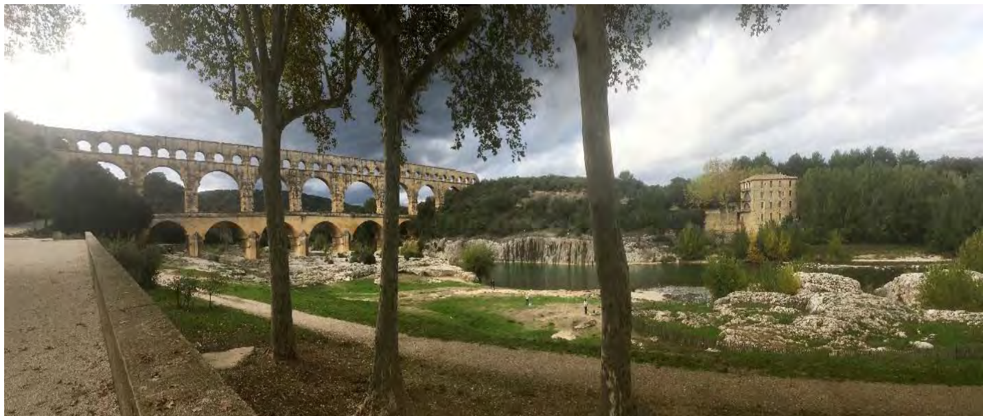
6. Le pont du Gard et, sur la rive gauche (à droite sur la photo), le moulin désaffecté, ancien hôtel-restaurant depuis les années trente (Photo JMB nov.2019).
