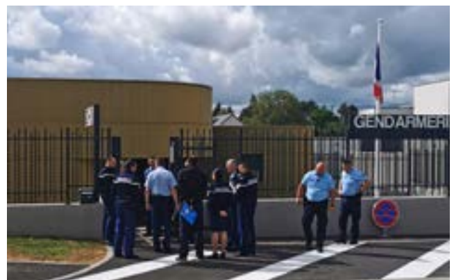
Visite de la nouvelle brigade de Selles-sur-Cher (41), première unité construite selon les normes du référentiel de sûreté des brigades.
