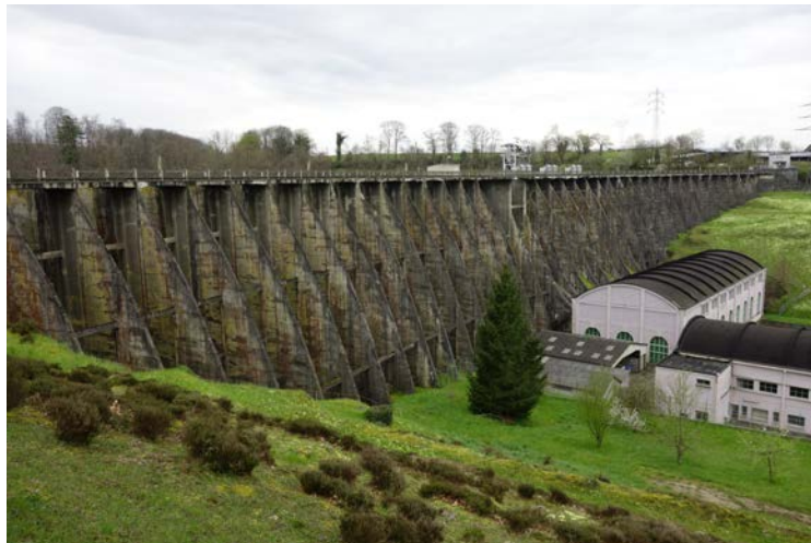
Illustration 7: vue de l'aval du barrage de Vezins montrant notamment les nombreux contreforts et les butons, poutres en compression qui les joignent (Photo CGEDD)
