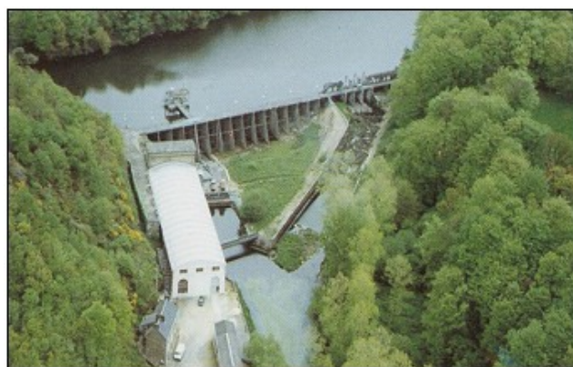
Illustration 4: photo aérienne du barrage de La Roche-qui-Boit
