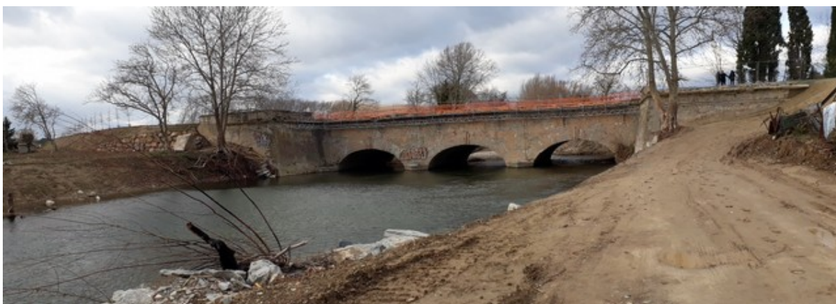
Traversée de l'Orbiel à Trèbes / pont canal : un dimensionnement à revoir ? Photo mission
