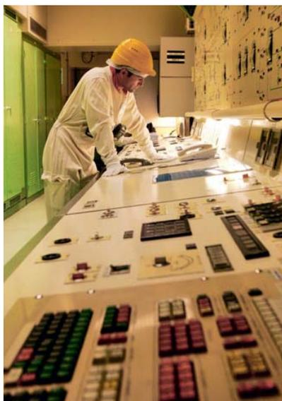
Salle de commande du bâtiment des auxiliaires nucléaires pour le traitement des effluents.
