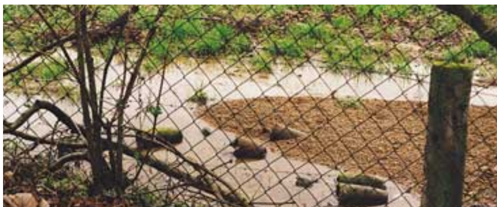
Site de l'entreprise Orflam-Plast (mars 1999).
