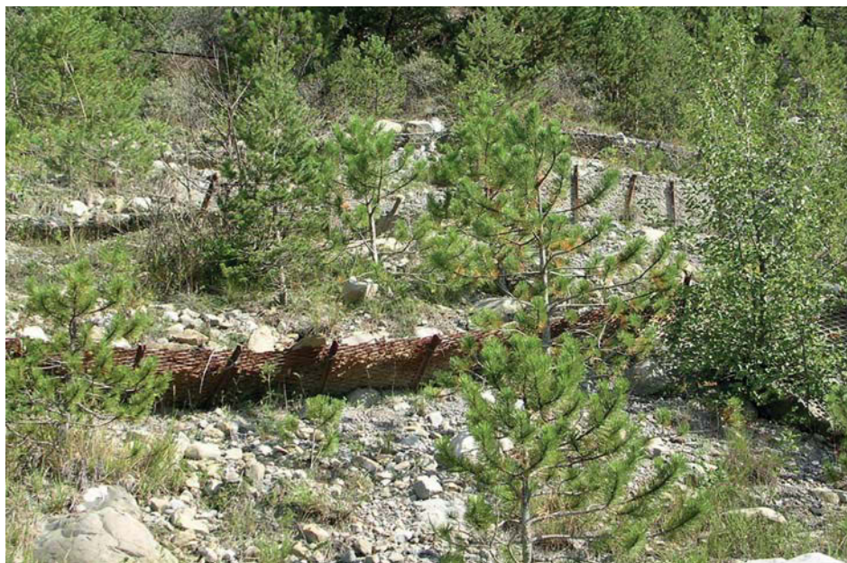
Figure 20 – Aménagements de lutte contre l'érosion
