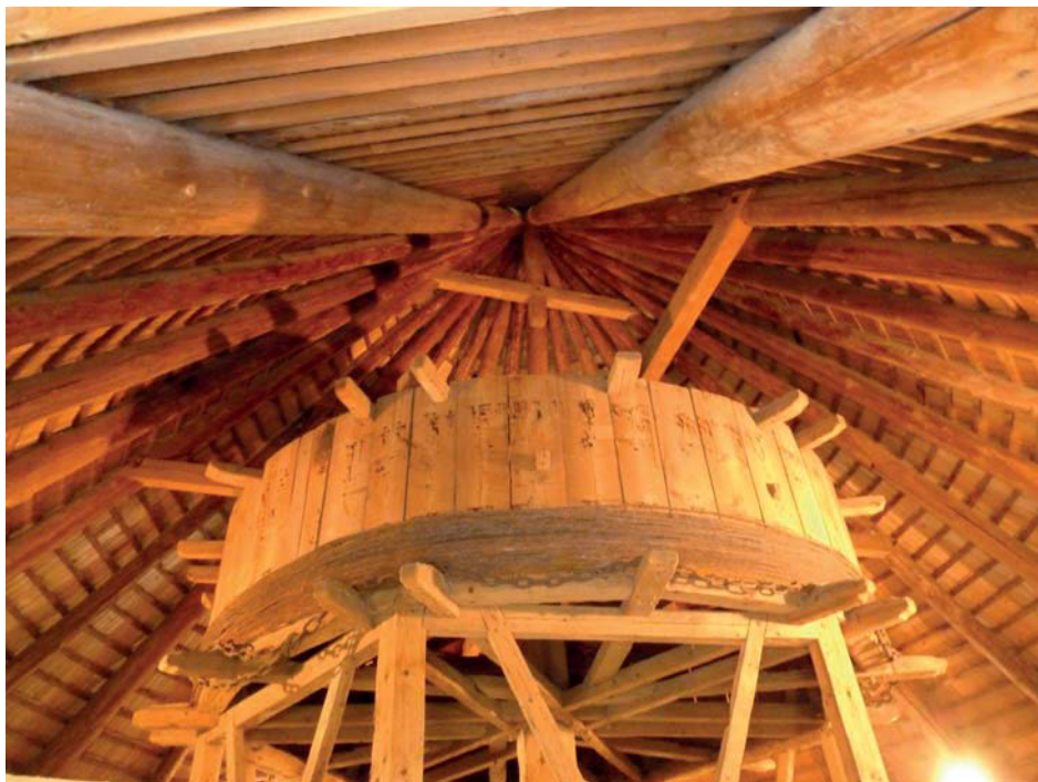
Figure 41 – Construction traditionnelle en bois pour l'exploitation des mines d'argent de Kutna Hora (République Tchèque)
